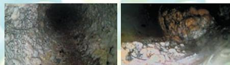
尿石が壁のように蓄積。毛と絡まり「鉄筋コンクリート」のような頑強さでした。
